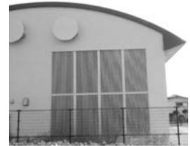
弊社はガスタービンコンバインドサイクルに於ける吸気フィルター用のアルミ製「ウェザールーバー」「遮音防水ルーバー」の製作を行っております。有効開口率が50%ありながら、台風時を上回る降水量と強風を用いた性能試験でも防水効率は99.9%。通気性にも優れたコストパフォーマンスの高い製品です。
