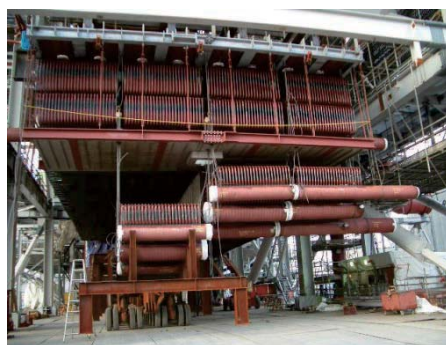
(2) Tube block of vertical type HRSG
