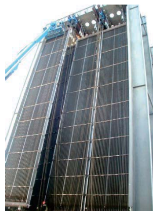
(1) Tube block of horizontal type HRSG
