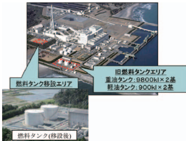
Fig.9 原町火力発電所復旧状況 (燃料タンク高台移設)
