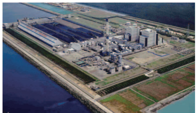
Fig. 3 能代火力発電所 全景
