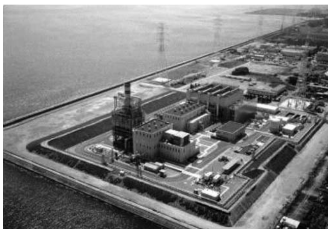
ガスタービン複合サイクル発電プラント実証設備
