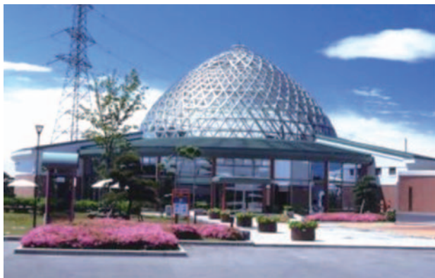
Fig. 4 能代火力発電所 エナジウムパーク
