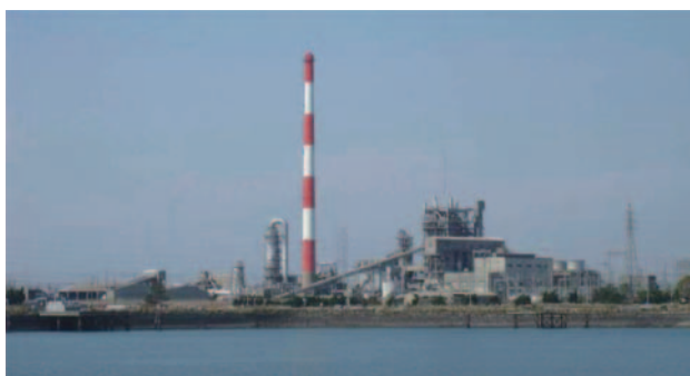
Fig. 6 三川石炭火力発電所
