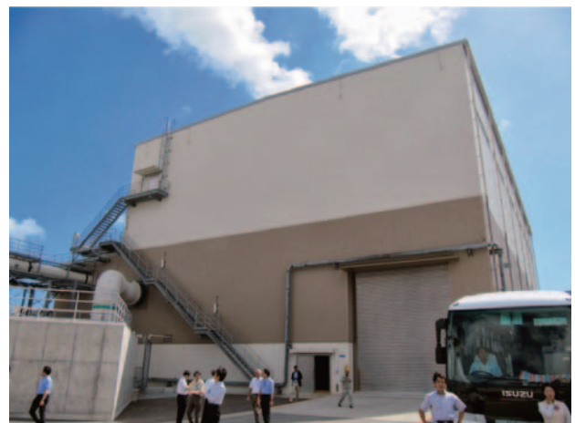
Fig. 3 吉の浦火力2号機建屋の見学の様子
