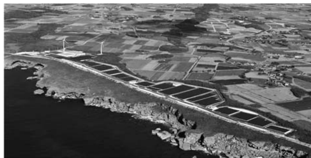
Fig. 6 宮古島メガソーラー発電設備
