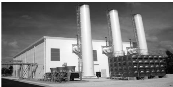
Fig. 4 宮古島ガスタービン発電所
