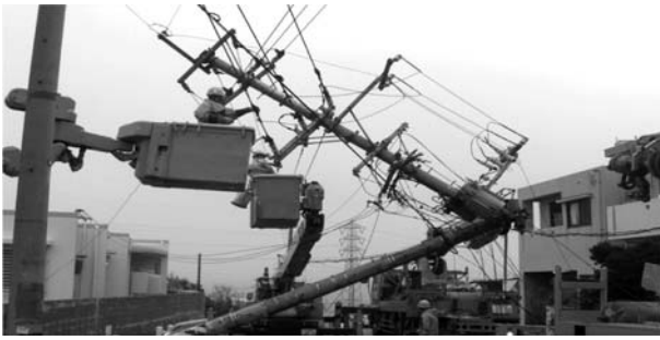
Fig. 8 配電設備の復旧作業
