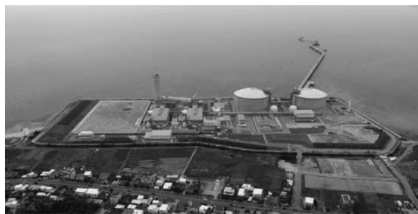
Fig. 3 吉の浦火力発電所 全景写真
