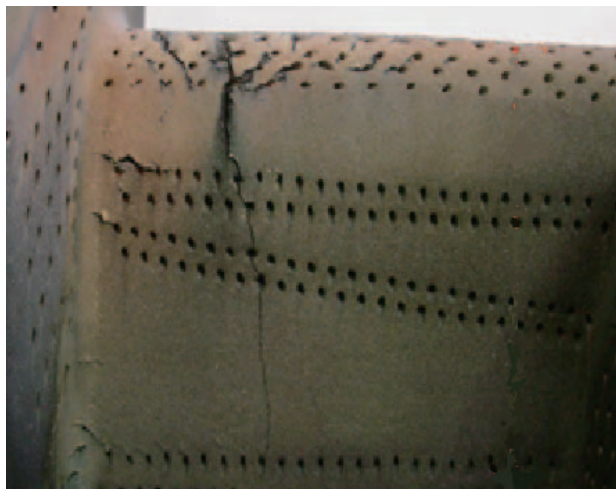
Fig.11 部品単体での不具合状況の観察 (クラック)
